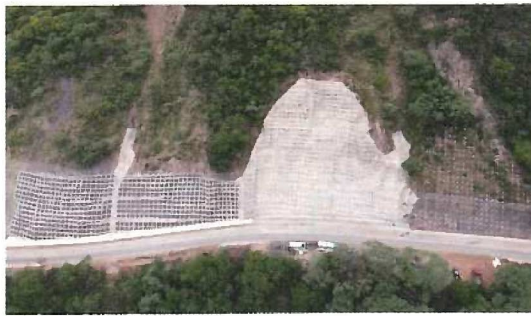
写真-5 斜面対策工完成時 (7-18 工区) (岩田地崎建設㈱ 撮影)
