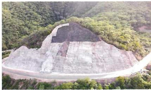
写真-6 斜面対策工完成時 (7-19 工区) (岩田地崎建設㈱ 撮影)
