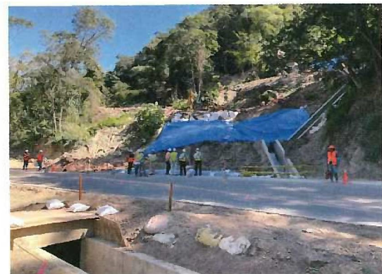
写真-3 施工現場(2023年6月筆者撮影)
